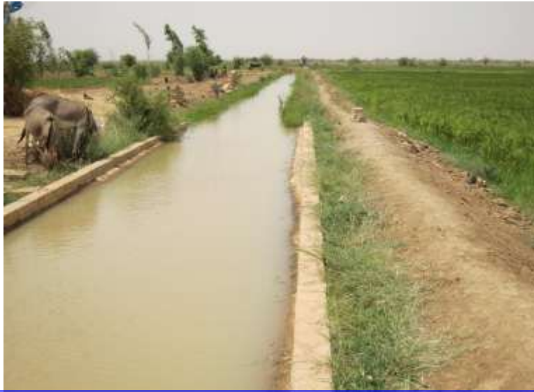
Réparation du canal principal
