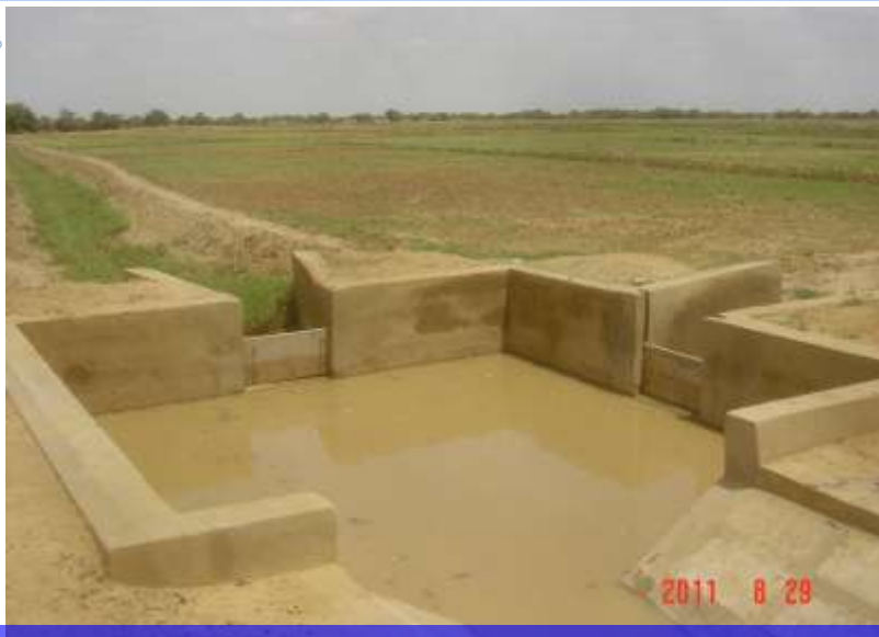
Réparation de répartiteur
