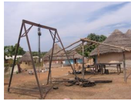
Fig5 : vue d'un atelier de réparation en plein air
