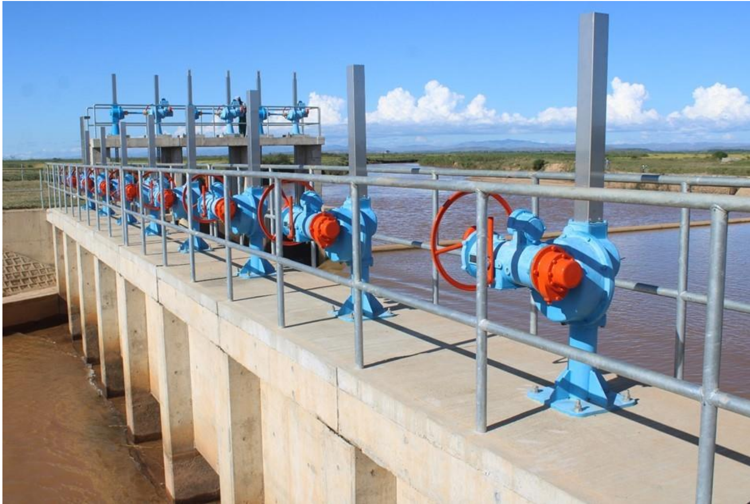
PC 23, Périmètre irrigué de 10 000 Ha, réhabilité dans la région Alaotra Mangoro, district d'Amparafaravola à travers le projet de non-remboursable financé par le Gouvernement du Japon
